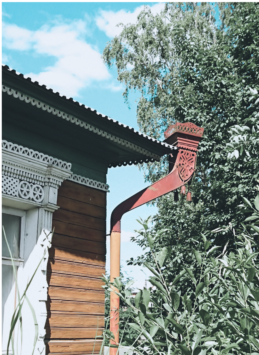
Резной водосток на доме в Центральном районе Тотьмы
